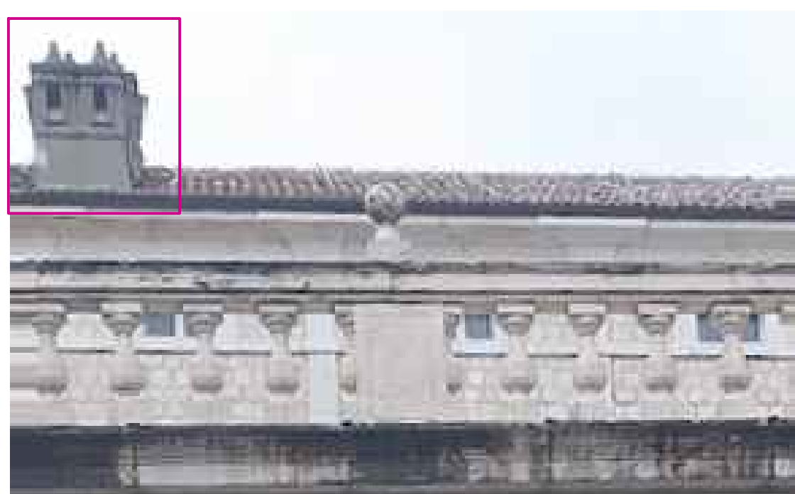
Fig. 6 - Dettaglio della copertura dell'archivio abbaziale visto dal Chiostro del Bramante. In evidenza, il comignolo.
